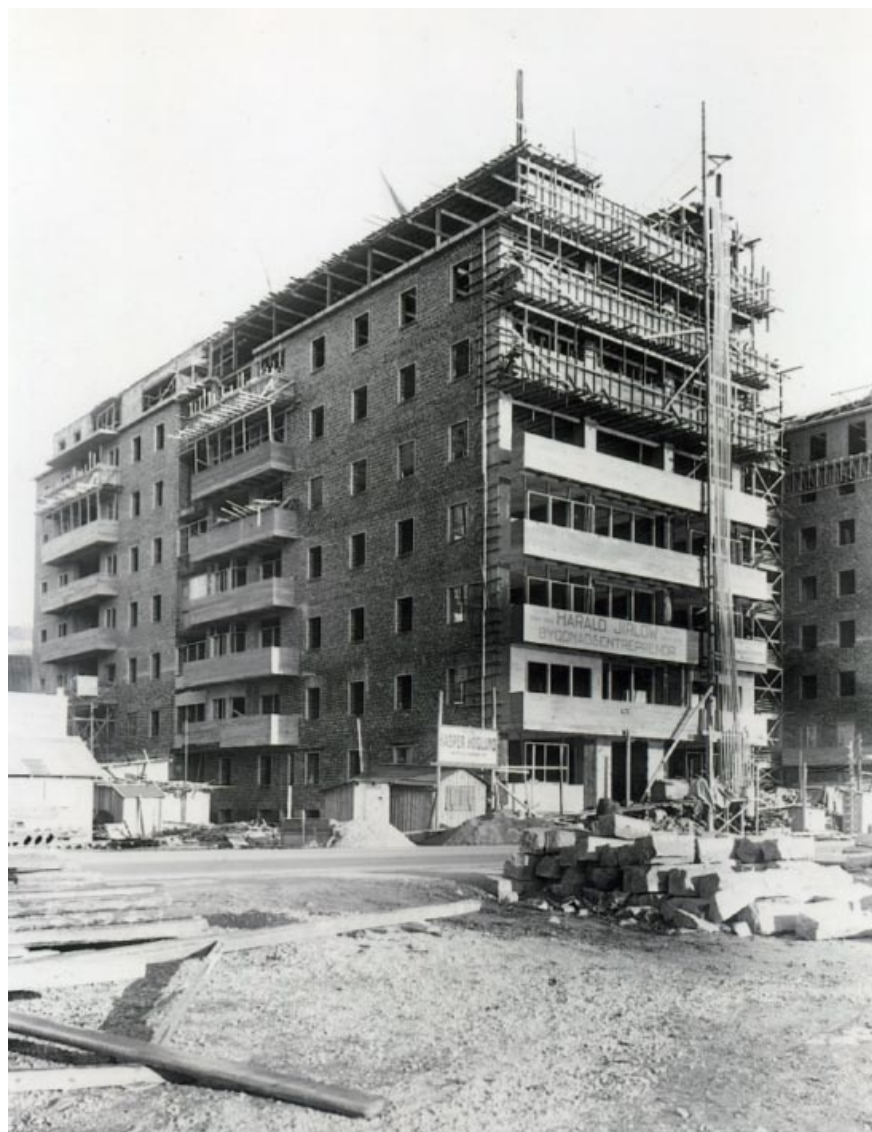
Byggmästare Harald Jirlow bygger Norr Mälarstrand 70 under 1930 - 31
